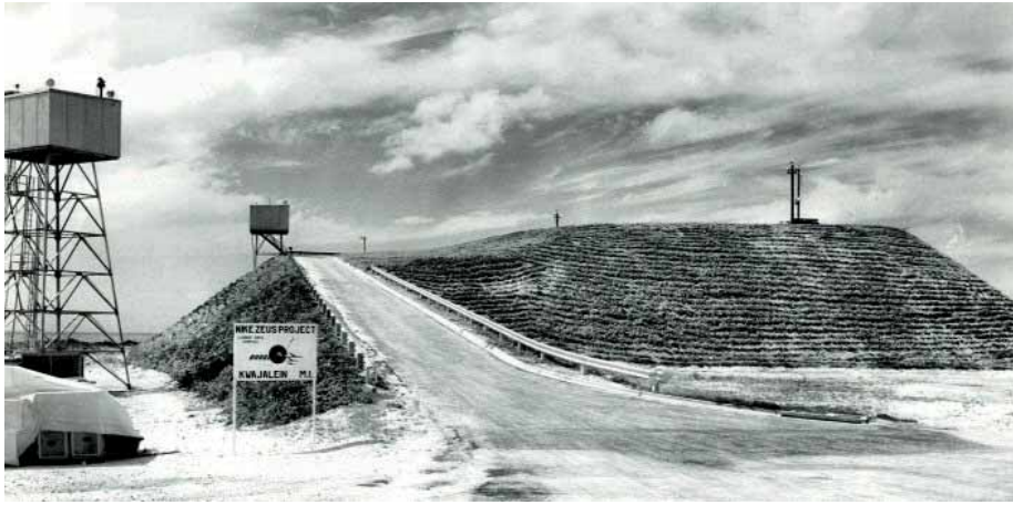
Il complesso di lancio del missile NIKE ZEUS sull'Isola di Kwajalein. Dato che l'atollo ha un'altezza sull'acqua di sole poche decine di centimetri, i silo interrati dei missile furono installati in un terrapieno costruito appositamente, chiamato Monte Olimpo.
